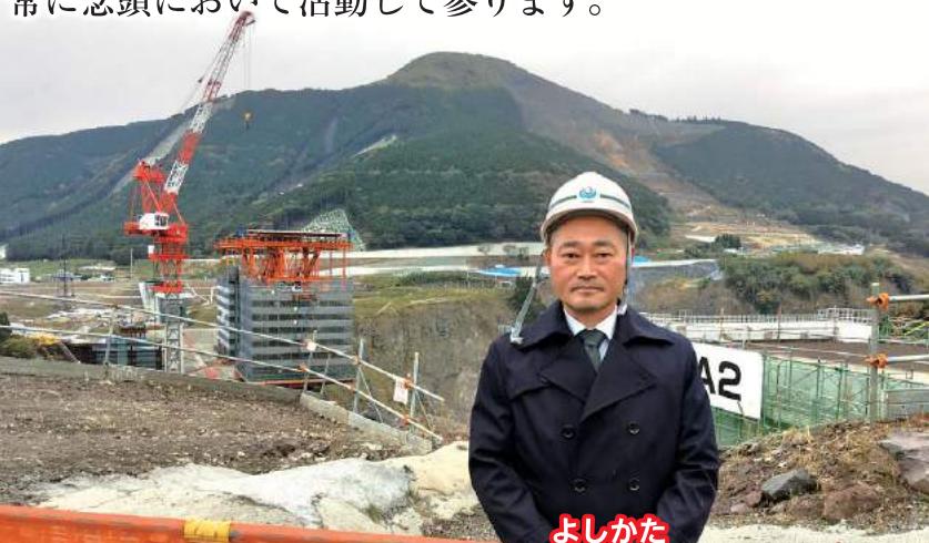
熊本県阿蘇大橋の復旧現場
